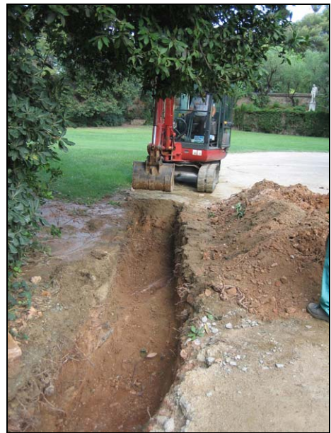
FOTO 4. Rasa 1. Ramal Nord-oest
