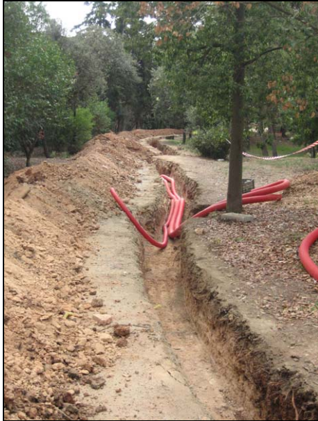
FOTO 21. Rasa 7 Tram Est
