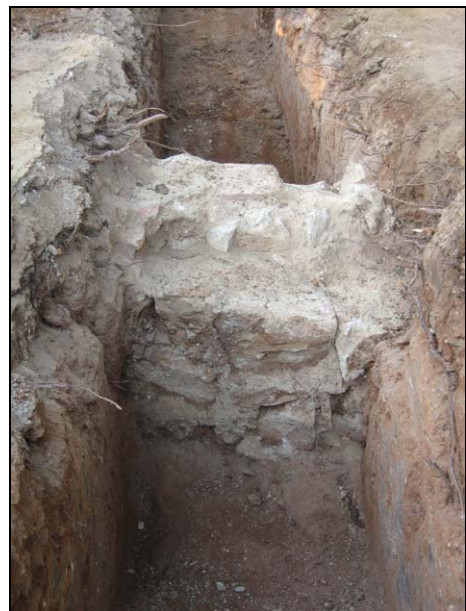
FOTO 24. Rasa 8 Mur UE 37
